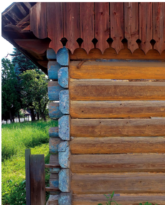
Dom w Małopolsce. Fragment ściany w konstrukcji zrębowej z ostatkami (fot. P. Wesółowski)
