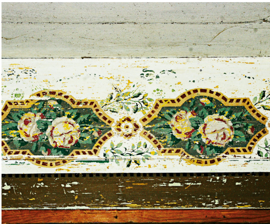
Malowany fryz patronowy na belce stropowej domu żuławskiego z początku XX wieku
