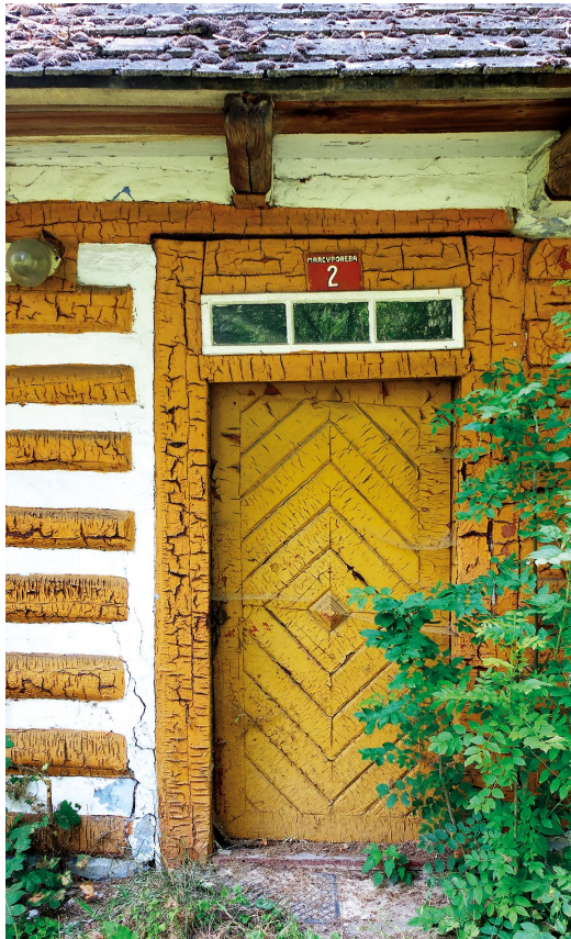
Drzwi w domu z Małopolski. Forma rombów akcentujących centralny punkt skrzydła wynikała zapewne z potrzeby optycznego podkreślenia głównego wejścia (fot. P. Wesółowski)
