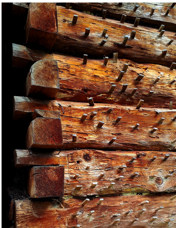
Dwór w Małopolsce. Fragment ściany w konstrukcji zrębowej z węglem z ostatkami i stelażem w postaci kołków dla tynku glinianego z sieżką (fot. A. Łapajerski)
