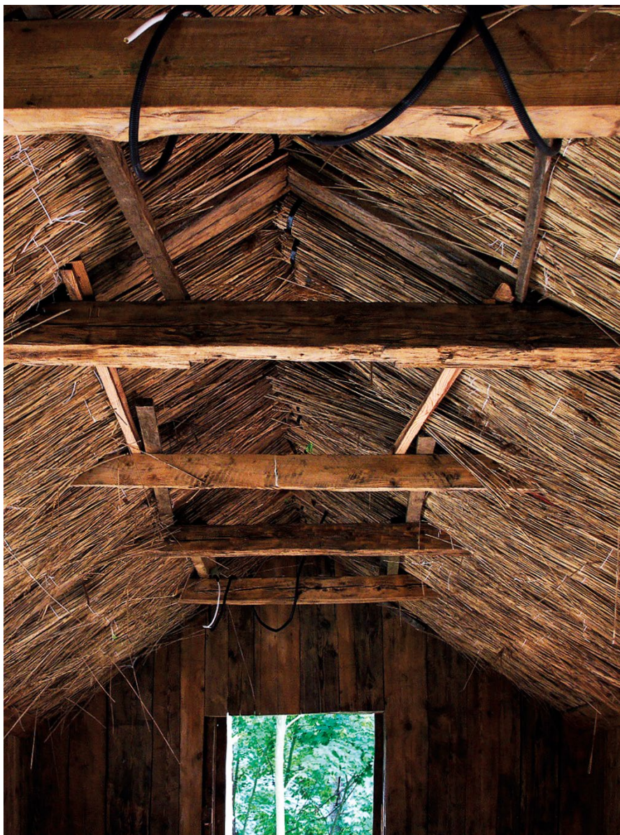
Docieplenie dachu snopkami trzcinowymi
