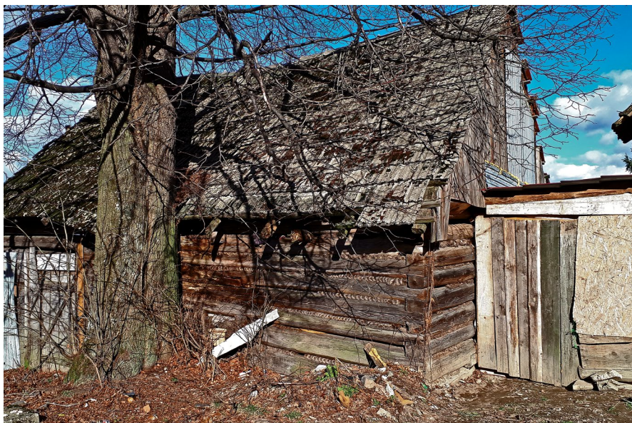
Konstrukcja zrębowa budynku gospodarczego w Małopolsce. Bliskie sadzenie drzew przy budynkach miało znaczenie symboliczne, ogromne, służyło wzmocnieniu fundamentów i regulacji wilgotności gruntu (fot. A. Łapajerski)
