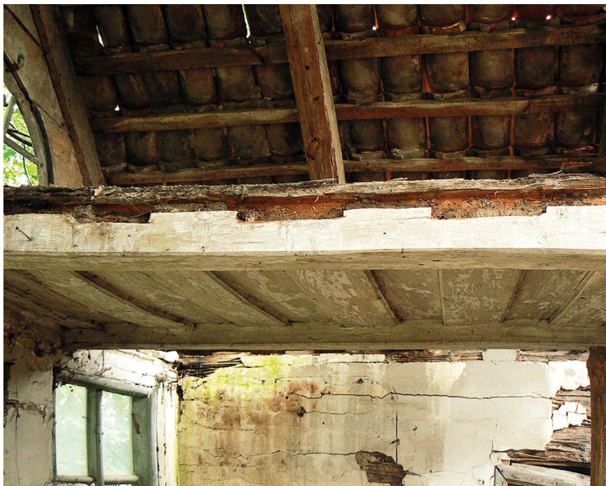
Belka stropowa z wpustami do sufitu polskiego w domu warmińskim z początku XIX wieku
