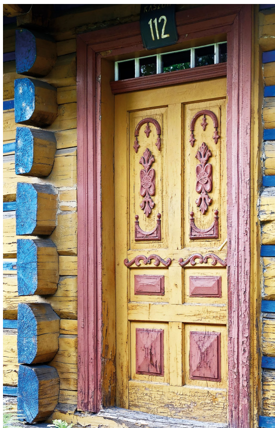
Ozdobne drzwi w domu drewnianym w Małopolsce (fot. P. Wesołowski)
