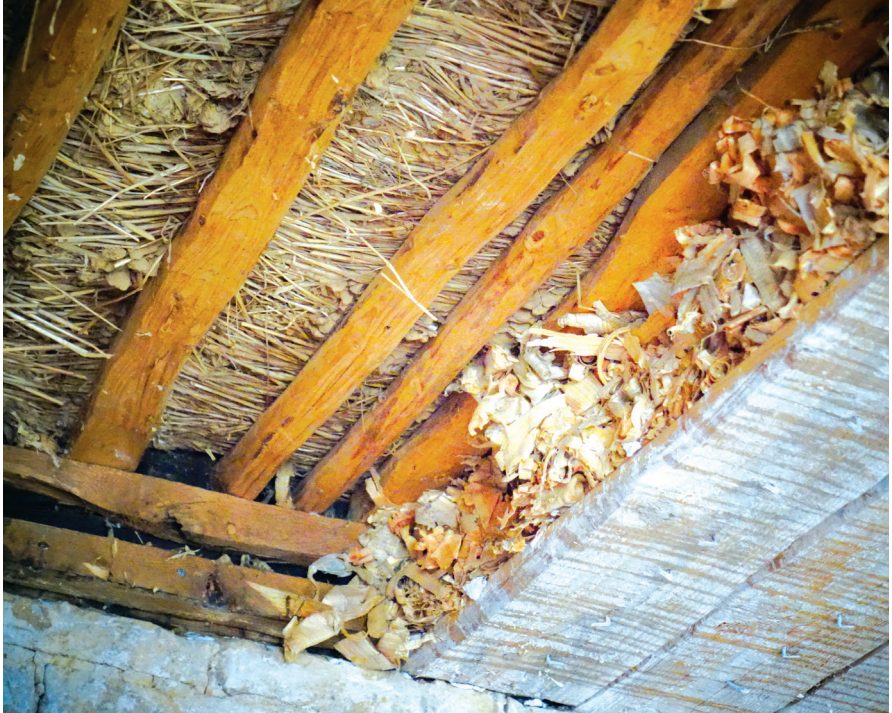
Strop budynku drewnianego ocieplony trzciną i wiórami drzewnymi
