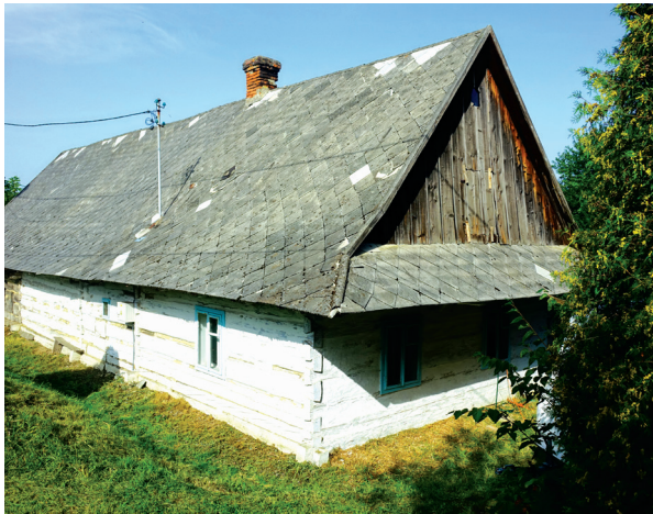
Budynek drewniany (chyża) z widocznym rowem odwadniającym na granicie skarpy przy podwalinach
